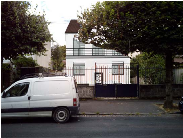
Visuel de loin côté Nord
